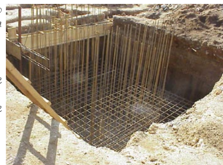
Fundação do futuro prédio da AMA no Cambuci
